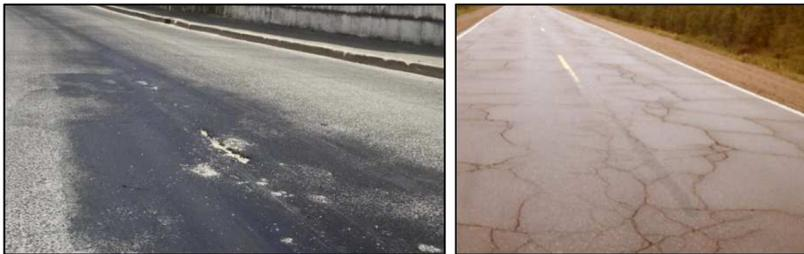
... proviennent du vieillissement des surfaces soumises aux intempéries et au trafic routier
