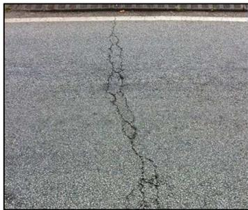
... proviennent du 1<sup>er</sup> niveau de dégradation de fissures non traitées.
