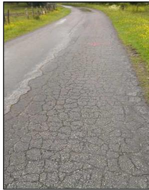
... proviennent des tassements du sol et de la rupture des matériaux de chaussées
