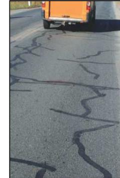
**Le pontage des fissures par mise en œuvre d'un mastic bitumineux appliqué à chaud**
