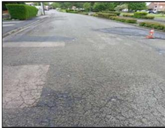
... proviennent du vieillissement des matériaux de chaussée (UV, instabilité), et peuvent amener avec les infiltrations d'eau, une dégradation rapide.
