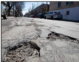
... proviennent de la propagation de la dégradation des fissures, pour aller jusqu'au décollement du roulement.
