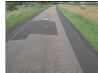
**Le répardage simultané de bitume et de gravillons par Point A Temps Automatique (PATA)**
