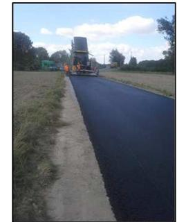
**Mise en œuvre de Béton Bitumineux tiède, Souple**
