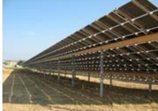
Structures fixes inclinées
