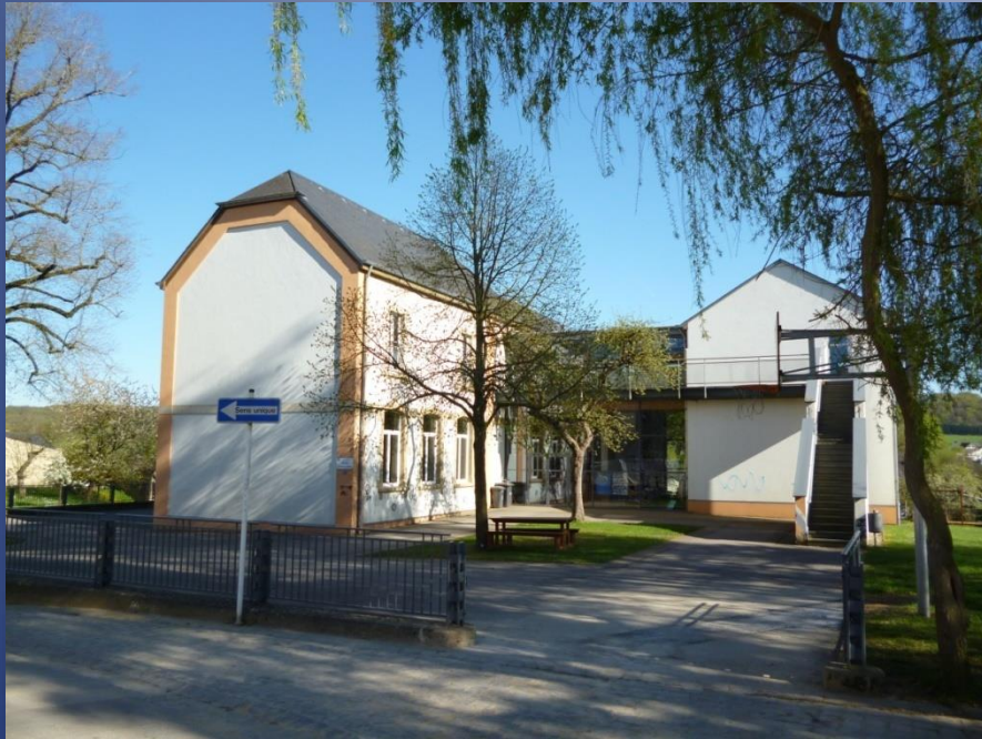
Ecole d'Oberpallen : bioconstruction (1994)
