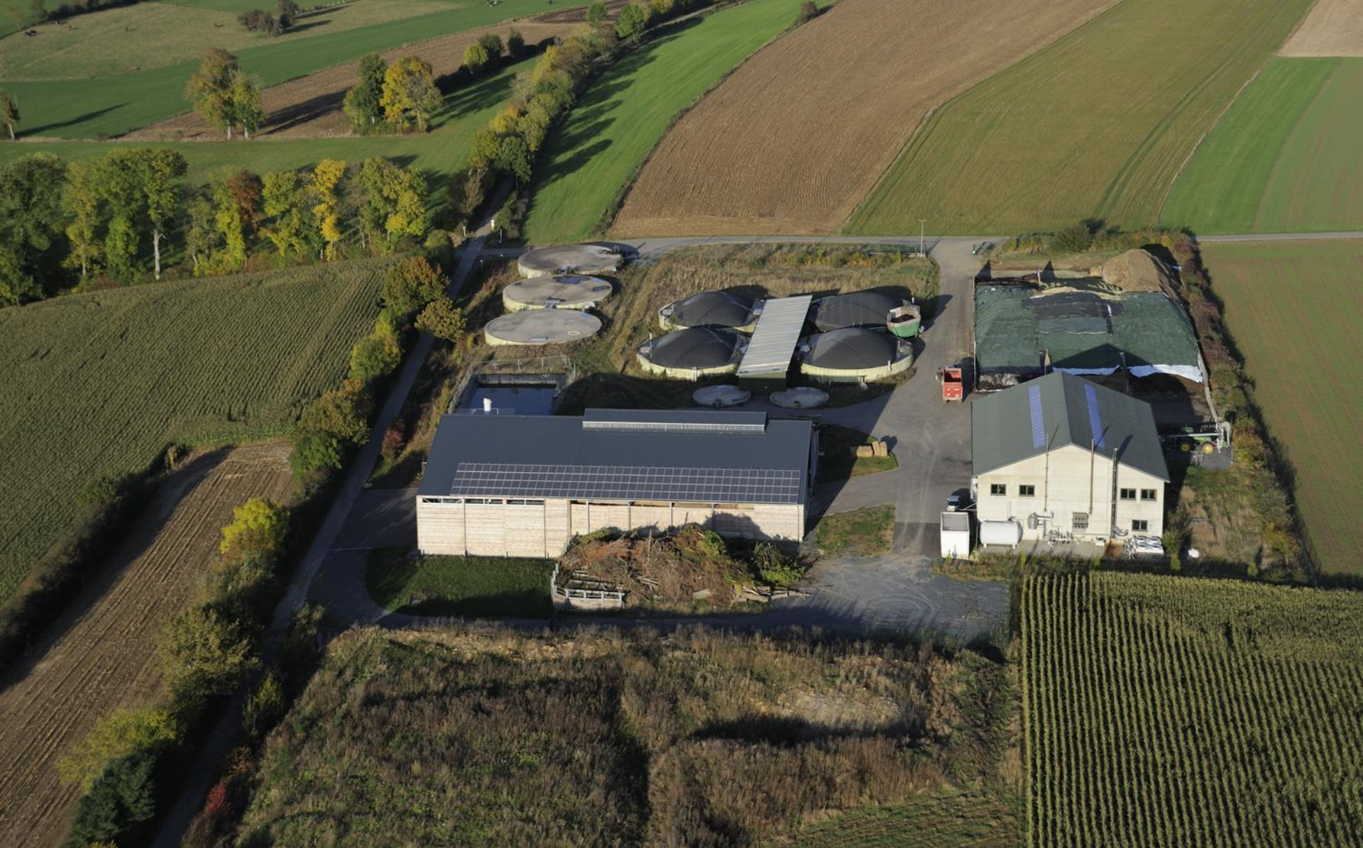
Usine de biométhanisation, hall de stockage et hall des 2 chaudières à copeaux de bois
