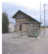
Abri vélos et halle fret existante
