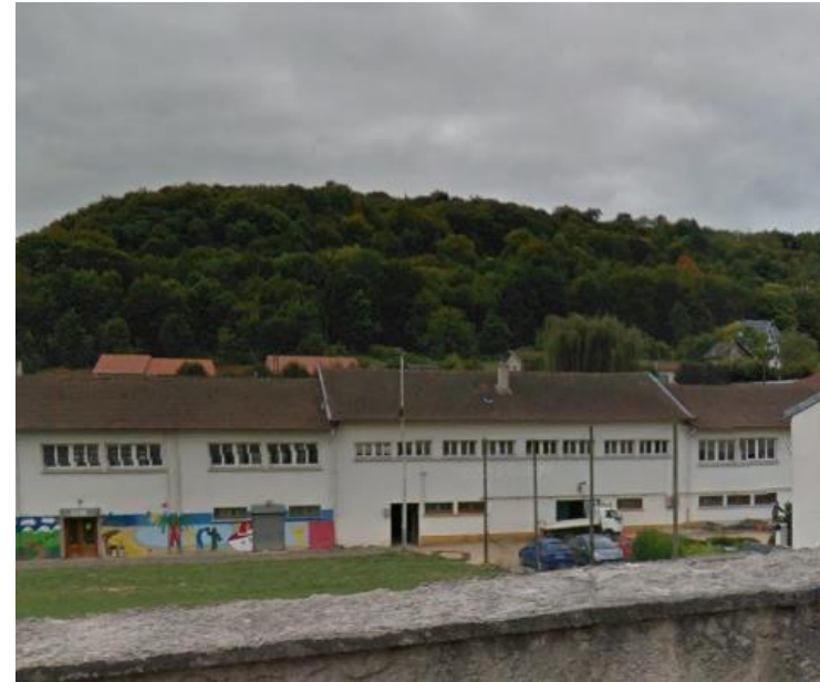
Façade nord de l'école - Source : Google maps
