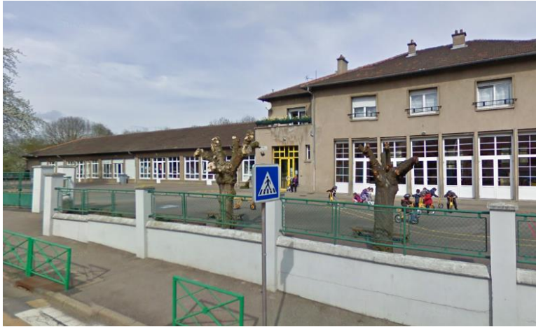
Façade sud de l'école - Source : Google maps
