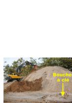
**A Veiller à ce que les dispositifs de coupure situés dans l'emprise des travaux restent accessibles pendant tous les travaux**
